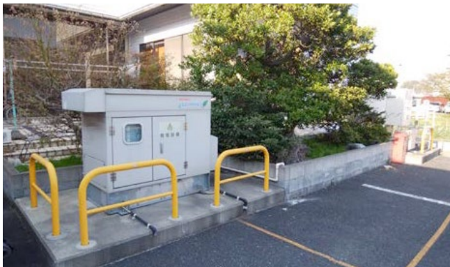
写真1：つばさハウスに設置してある発電機 植え込みをはさんだところに液化プロパンタンクが設置してある
